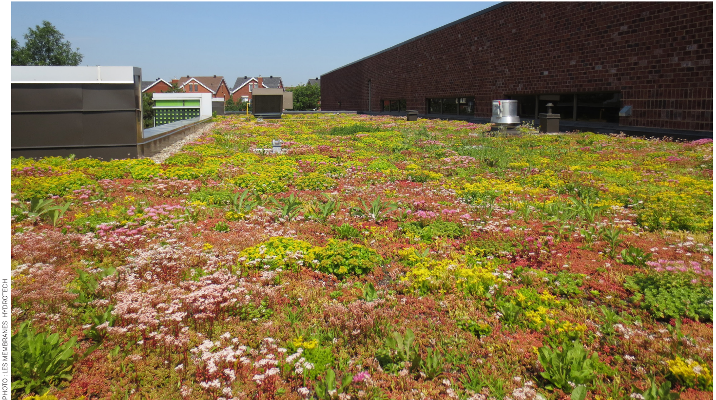
Toiture végétalisée extensive
