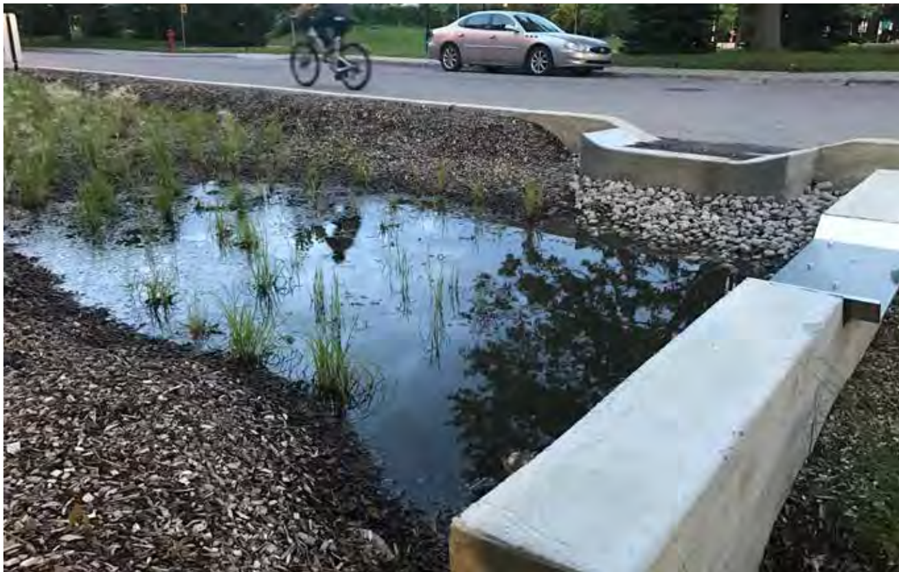
Bassin de biotérention (appelé aussi jardin de pluie) qui vise à capter, à retenir et à traiter de façon écologique le ruissellement provenant des eaux de pluie.
