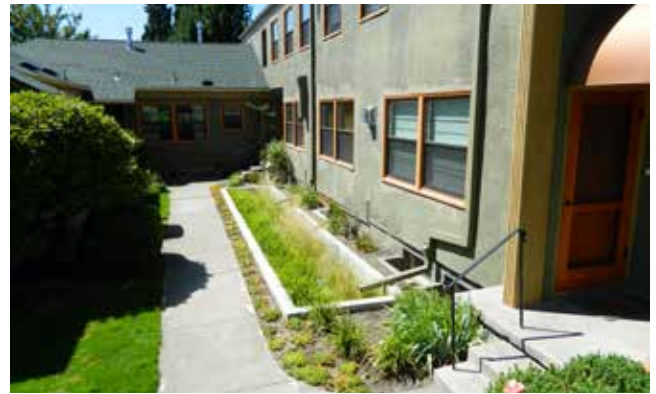
Une façon efficace de gérer l'eau de pluie
