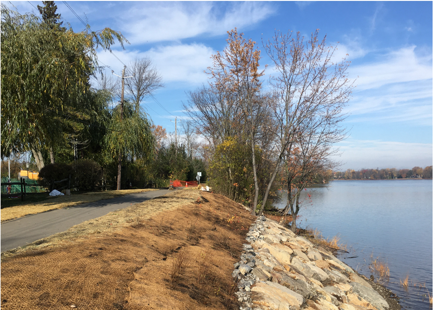
Matelas de branches avec base d'énrochement
